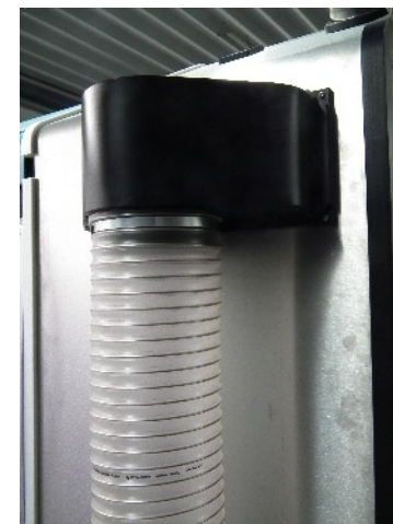
Anschluss Schlauch vom Klimamodul
