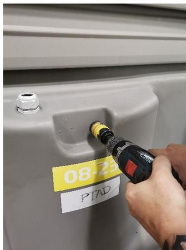
Setzen Sie das Anschlussstück mit der Dichtung von außen ein und schrauben Sie das Gegenstück mit der Flachdichtung von innen auf.
