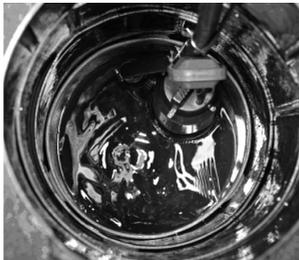
2. Tauchpumpe in den Schacht hinablassen. Zur Entsorgung des Wassers siehe Absatz Seite 11.
