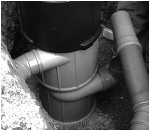
**4.** Optimal wäre eine Höhendifferenz von 680 mm zwischen den ankommenden Regenrohren und dem unteren Zulauf in den Filter. Hier in unserem Beispiel nimmt man einen kurzfristigen Rückstau in das bestehende Leitungssystem in Kauf. Auf Dichtheit der Anschlüsse und der erdverlegten Leitungen ist zu achten.
