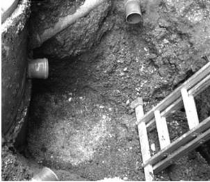
**1.** Ausheben der Baugrube: Hier wird der nachträgliche Einbau vor einem Regenspeicher gezeigt. Planen, festen Untergrund gemäß den entsprechenden Höhen schaffen. Der Zulauf in den Speicher ist hier die maßgebende Höhe.
