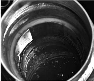
1. Blick in den Schacht nach dem Herausheben des Schlammfangs.
