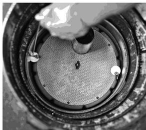
5. Auftriebssicherung nach außen drehen, zweite Sicherung nach außen drehen.
