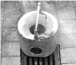
4. Schlammmeimer von außen mit Wasserstrahl reinigen.
