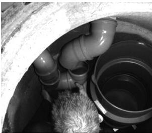
4. Filtergehäuse auf die Halterung stellen. Rohre mit entsprechenden Bögen anschließen. **Tipp:** Zum Zuschneiden die Dichtungen aus den Muffen nehmen, so lassen sich die Rohre leichter stecken. Wenn alles passt, Dichtungen einsetzen und mit Schmiermittel die Rohre zusammenstecken.
