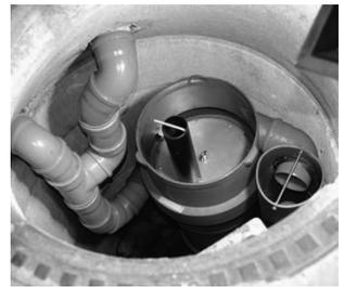
6. So sieht ein fertig installiertes Hydrosystem 400 im Schacht aus. Bei dieser Anlage wurde noch aufgrund behördlicher Forderung eine kleine Ölsperre eingebaut, um in Havariefällen gesichert zu sein. (Dieser Schacht lag in einer Tiefgarage).
