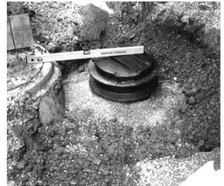
**6.** Die Teleskopverlängerung mit Deckel an dem gewünschten Niveau mit Hilfe einer Wasserwaage ausrichten und die Kragen der Teleskopverlängerung mit Sand oder feinem Splitt unterfüttern. So liegt der Druck nicht auf dem Hydrosystem 400 und auf den Rohren.
