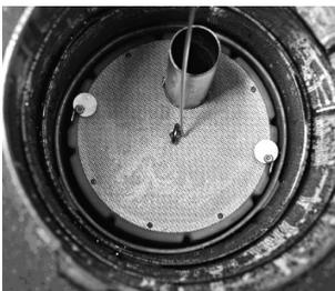
4. Filterelement mit dem Werkzeug in den Schacht herablassen und darauf achten, dass das Überstandrohr mit der Abschlusskappe verschlossen ist.
