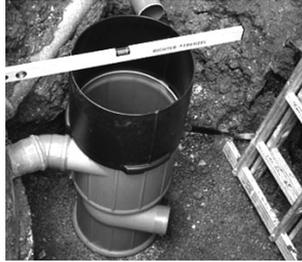
**2.** Filter an den Zulauf des Speichers anschließen, waagerechte Lage kontrollieren.
