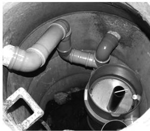
5. Rohre und alle Verbindungen überprüfen (Dichtungen alle vorhanden, sauberer Sitz). Rohre mit Rohrschellen arretieren, um bei einer späteren Wartung genügend Halt bei der Entnahme des Filtereinsatzes zu haben. Evtl. Rohre mit kleinen Edelstahlschrauben gegen Verdrehen sichern.
