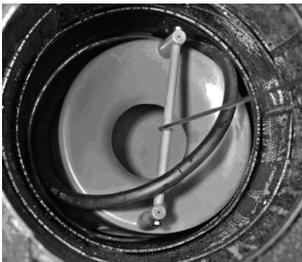
1. Schlammeimer und Dichtung mit dem Werkzeug wieder einsetzen.
