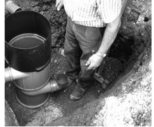
**3.** Zulauf Regenwasser anbringen. Am günstigsten ist es, den Absturz vor dem Filter zu montieren. Dazu 87°-Bogen am unteren Anschluss anbringen und die Regenwasserleitung / Regenwasserleitungen anschließen.
