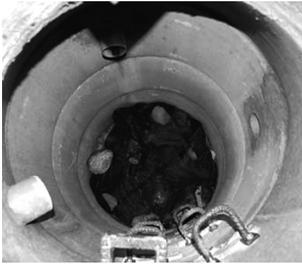
1. Schacht für den Einbau vorbereiten. Zulaufleitungen kontrollieren. Genügend Bögen und Leitungen für den Anschluss bereithalten.
