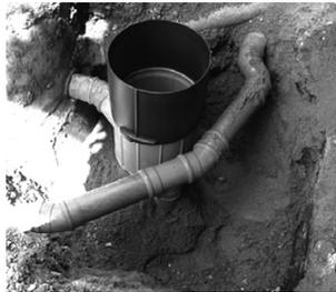
**5.** Nachdem alle Verbindungen geprüft worden sind, werden das Filtergehäuse und die Leitungen eingesandet. Die Leitungen sind dabei gut zu unterstopfen, damit sie beim Verfüllen der Baugrube nicht beschädigt werden.
