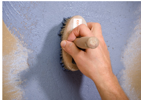
Lehm-Streichputz im Kreuzschlag auftragen
