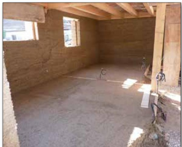
Bodenplatte: Einbringen der ca. 20 cm starken Bodeplatte aus HANF.bioton
