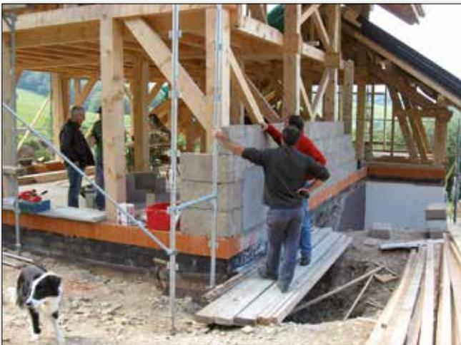
Isolierung mit HANF.bioton-Steinen: Dämmende Vorsatzschale für die Innen- und Außenisolierung
