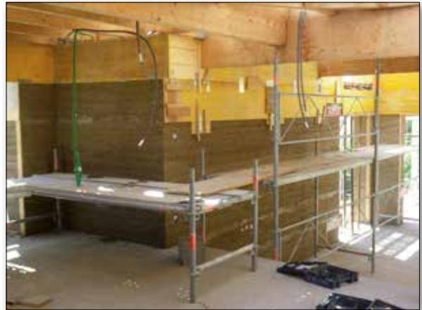
Aufbau der HANF.bioton-Wände: Die Wandstärke beträgt 40 cm. Der HANF.bioton wird in Schichten von ca. 15 cm in die Gleitschalung eingebracht und dabei an der Schalungswandung und um die Stützbalken zusätzlich verdichtet.
