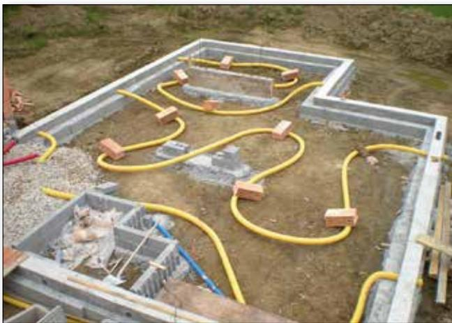
Drainage und Bodenplatte: Gut zu sehen ist der Einbau einer Drainage mit gegenseitiger Belüftung auf einer kapillarbrechenden Schicht
