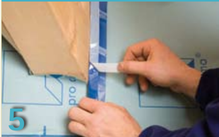
Detail Eckverklebung
