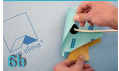
Detail Kabeldurchführung
