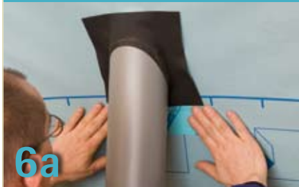
Detail Rohrdurchführung
