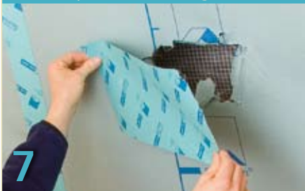
Detail Reparaturverklebung
