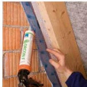
pro clima CONTEGA PV am Mauerwerk durch Ankleben mit ORCON F oder Annageln punktuell befestigen. Bei weichen Untergründen, z.B. Gasbeton-, Bims- oder Hohlblocksteinen kann in die Steine, bei harten Untergründen in die Mauerwerksfugen genagelt werden. Das Hohlliegen des Bandes ist zu vermeiden, d.h. die Befestigung am Mauerwerk muss im oberen Bereich des Bandes erfolgen.
