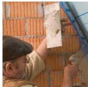
CONTEGA PV in die Mittellage des Putzes einbetten. Dazu Vlies und Armierung wieder zurückschlagen, Putz auf der Wand, hinter CONTEGA PV auftragen, Vlies und Armierung in den frischen Vorputz legen und vollständig einputzen.
