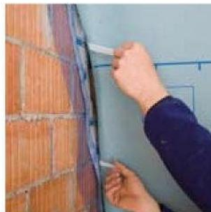
Dampfbremse heranzuführen. Trennfolienstreifen am CONTEGA PV abziehen und Vlies mit Klebestreifen auf Luftdichtungsebene fixieren. Dehnschlaufe ausbilden. Kleber fest anreiben.
