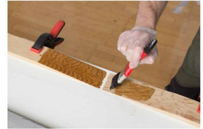
4 - Auftragen von Epoxidharz auf die Klebeflächen
