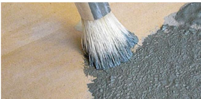
Sehr schön sind Schablonierungen mit Spachtelmassen. Bei Spachtelarbeiten wird mit kleiner Venezianerkelle oder Japankelle mit wenig Druck gearbeitet.
