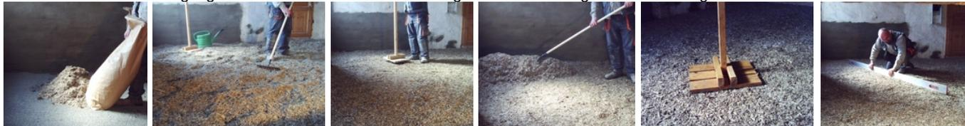
Jede Lage ist mit Harke oder Rechen zu ebenen, mit dem Holzstampfer zu verdichten und zu glätten, wodurch sich die Hanfspäne waagrecht legen und die durch das Schütten verursachten Luftpolster zwischen den Hanfspänen entweichen, und abschließend zu nivellieren. Eventuelle Nivellierleisten nur in die letzte Schicht einbetten.
