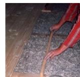
Vor dem Verlegen von kammergetrockneten Dielen, sollte die Hanf-Lehm-Schallschüttung 2 Tage abtrocknen.
