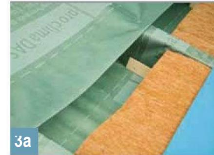
3a Nächste Lage ausrollen. Die Bahnenüberlappung sollte ca. 10 cm betragen. Die aufgedruckte Markierung dient als Orientierungshilfe.
