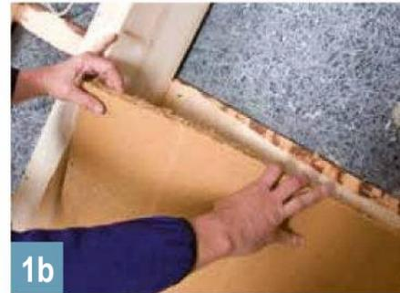
1b Zum Schutz der DASATOP einen plattenförmigen Dämmstoff mit festerer Struktur auf der vorhandenen Innenbekleidung verlegen. Stärke der Dämmung unter der DASATOP max. 1/3 der Gesamtdämmstärke.
