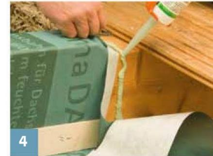
4 Für Anschlüsse an raue oder mineralische Bauteile eine ca. 5 mm breite Kleberraupe ORCON F aufbringen. Kleber nicht ganz flach drücken, damit Bauteilbewegungen aufgenommen werden können.
