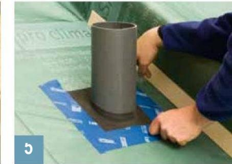
5 Anschlüsse an Rohr- und Kabeldurchdringungen mit Luftdichtungsmanschetten und falls erforderlich TESCON No.1 herstellen. Anschlüsse an Dachflächenfenster erfolgen mit dem Eckklebeband TESCON PROFIL.
