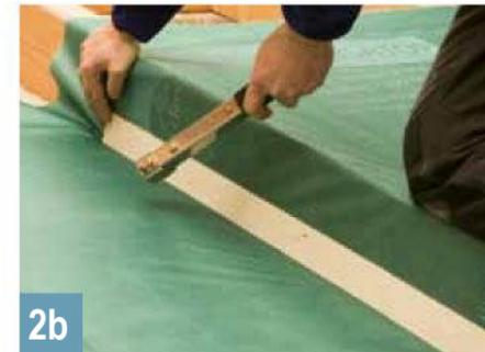
2b Bahn an Sparrenflanken mit ca. 3 mm starken Sperrholz- oder Hartfaserstreifen in der unteren Ecke der Sparrenflanke fixieren. Befestigungsstreifen durchgehend verwenden. Einfache Fixierung z. B. mit einem Schlagtacker.
