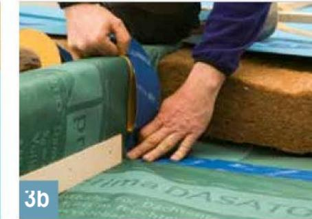
3b Luftdichte Verklebung der Bahnenüberlappungen mit den System-Klebebändern TESCON No.1 / TESCON VANA. Band mittig ansetzen und mit dem pro clima PRESSFIX fest anreiben.
