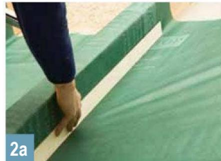
2a Bahn horizontal (quer zu den Sparren/Deckenbalken) verlegen. Am aufgehenden Außenmauerwerk beginnen. Bahn an Sparrenflanken und Untergrund vollflächig anliegend verlegen und sauber in die Ecken drücken. Konvektionstunnel vermeiden.
