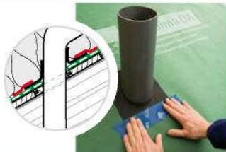
Durchdringungen von Rohren durch die Aufdachdampfbremse werden mit den pro clima Manschetten luftdicht und feuchtegeschützt abgedichtet. Alternativ kann die Abdichtung
