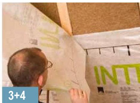
Nachdem die erste Bahn sitzt, wird die zweite Lage montiert. Die Bahnen ca. 10 cm überlappen lassen. Die aufgedruckte Markierung dient dabei zur Orientierung.
