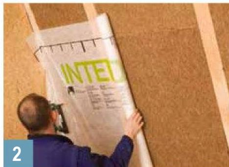
Raumseitig unter der Dämmung wird die INTELLO Dampfbrems- und Luftdichtungsbahn verlegt. Die Verklebung mit Klebebändern soll auf der glatten Schriftseite erfolgen. Tackerklammern sollten
