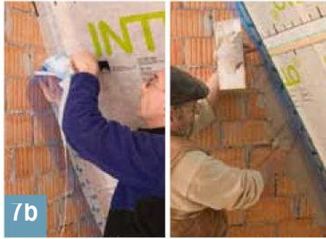
Bei Mauerwerk, welches noch verputzt werden soll, sorgt das Putzanschlussband CONTEGA PV für definierte luftdichte Übergänge. Das Band wird zunächst mit seinem Selbstklebestreifen auf der glatten Seite der Dampfbremse befestigt.
