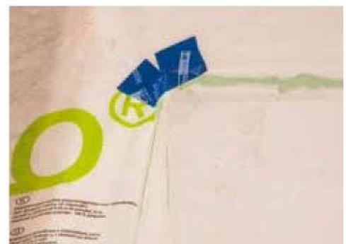
TESCON VANA abdichten. Das Klebeband mittig bis zur Hälfte einschneiden. So kann es einfach angeformt werden.
