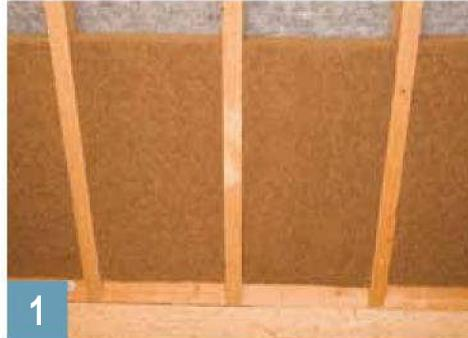
Zwischen den Sparren wird gedämmt. Wir zeigen hier die Verwendung eines mattenförmigen Dämmstoffs. Wichtig ist es, darauf zu achten, dass keine Fugen und Ritzen zum Sparren und zwischen den Dämmmatten entstehen.
