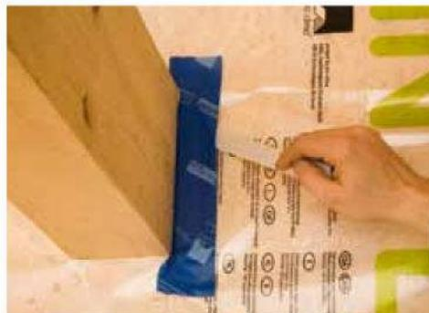
Im zweiten Schritt einfach die restlichen Trennstreifen entfernen und die Verbindung komplett herstellen.
