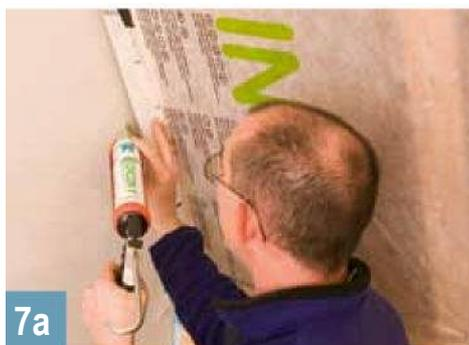
Für Anschluss an verputzte Giebelwand Allround-Anschlusskleber ORCON F direkt aus der Kartusche in einer ca. 5 mm dicken Kleberraupe auftragen. Bei rauen Untergründen Raupendurchmesser ggf. vergrößern.
