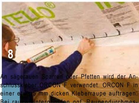
An sägerauen Sparren oder Pfetten wird der Anschlusskleber ORCON F verwendet. ORCON F in einer etwa 5 mm dicken Kleberraupe auftragen. Bei rauen Untergründen ggf. Raupendurchmesser vergrößern.
