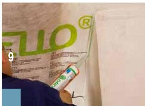
Für Anschlüsse zu gedämmten, zweischaligen Schornsteinen INTELLO ca. 3 cm auf den Schornstein führen. Eine etwa 5 mm dicke Kleberraupe (ggf. mehr) mit ORCON F auftragen und die Bahn mit einer Dehnschleife in das Kleberbett legen. Dabei den Kleber nicht ganz flach drücken. Ecken mit kurzen Stücken TESCON No.1 oder
