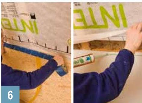
Genauso wichtig wie die Verklebung der Überlappungen sind die Anschlüsse zu angrenzenden Bauteilen. Dabei wird an glatte, nichtmineralische Bauteile (wie hier Drempele aus OSB-Platten) mit TESCON No.1 oder TESCON VANA angeschlossen.
