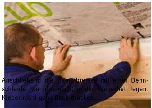
Anschließend die Dampfbremse mit einer Dehnschleife (wenn möglich) in das Kleberbett legen. Kleber nicht ganz flach drücken.
