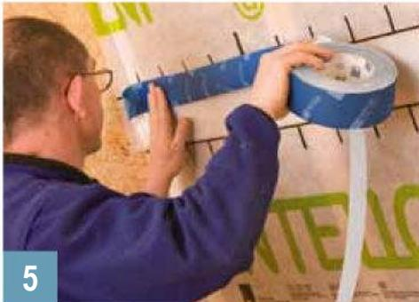
Im Überlappungsbereich Bahnen mit dem Klebeband TESCON No.1 oder TESCON VANA zug- und lastfrei verkleben. Falten im Überlappungsbereich dürfen nicht überklebt, sondern müssen aufgeschnitten und neu verklebt werden.
