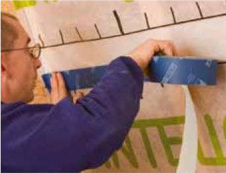
Feuchtevariable Dampfbrems- und Luftdichtungsbahn.
