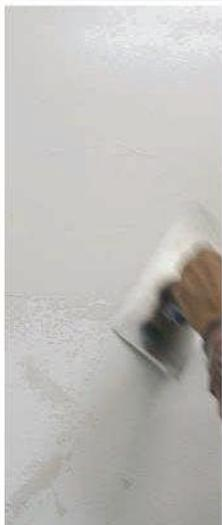
Der Profi-Kalkspachtel gleicht ungleichmäßig saugende Untergründe, z. B. Gipskartonplatten vor dem Anstrich mit Profi-Kalkprodukten aus. Er eignet sich sowohl zur Ausbesserung kleiner Fehlstellen als auch zur Egalisierung des Untergrundes. Die pulverförmige Spachtelmasse zum Selbstanrühren ist hoch diffusionsoffen und kann mit einem Spachtel oder Glättkelle bis max. 3 mm Schichtdicke aufgetragen werden.
